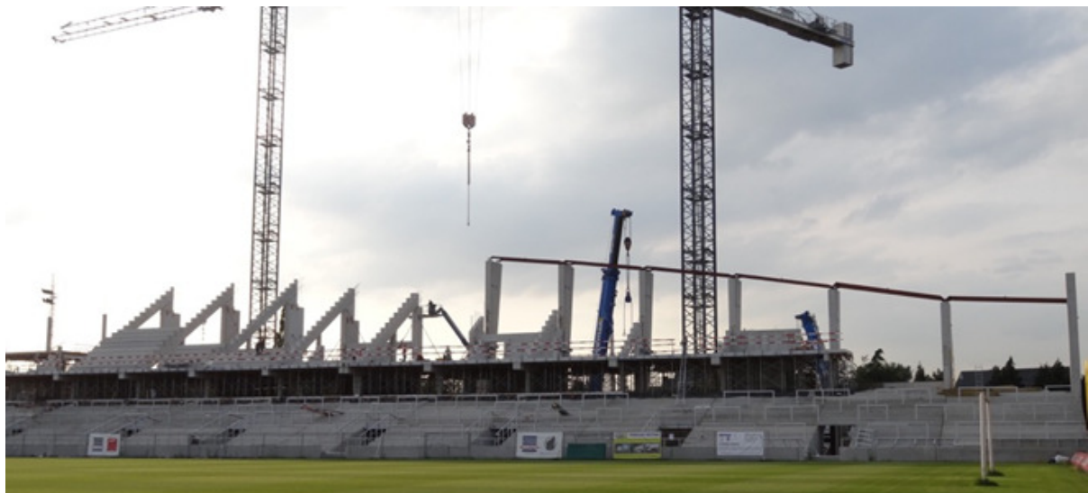
De stand van zaken op de bouwwerf in Mechelen.
